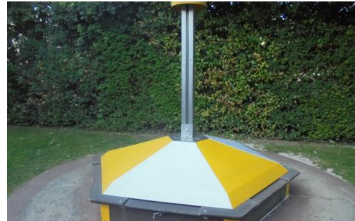
Exemple de couvercle de bac à sable permettant de limiter la rétention d'eau de pluie
